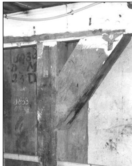
Stijl, korbeel en bintbalk in de schuur. Op de achtergrond links een wandje van staand schot met daarop geschilderde initialen en jaartallen uit o.a. 1833
